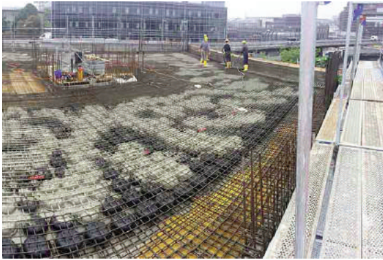
Công nghệ sàn lõi rỗng Cobiax được áp dụng trong dự án tại Hannover
